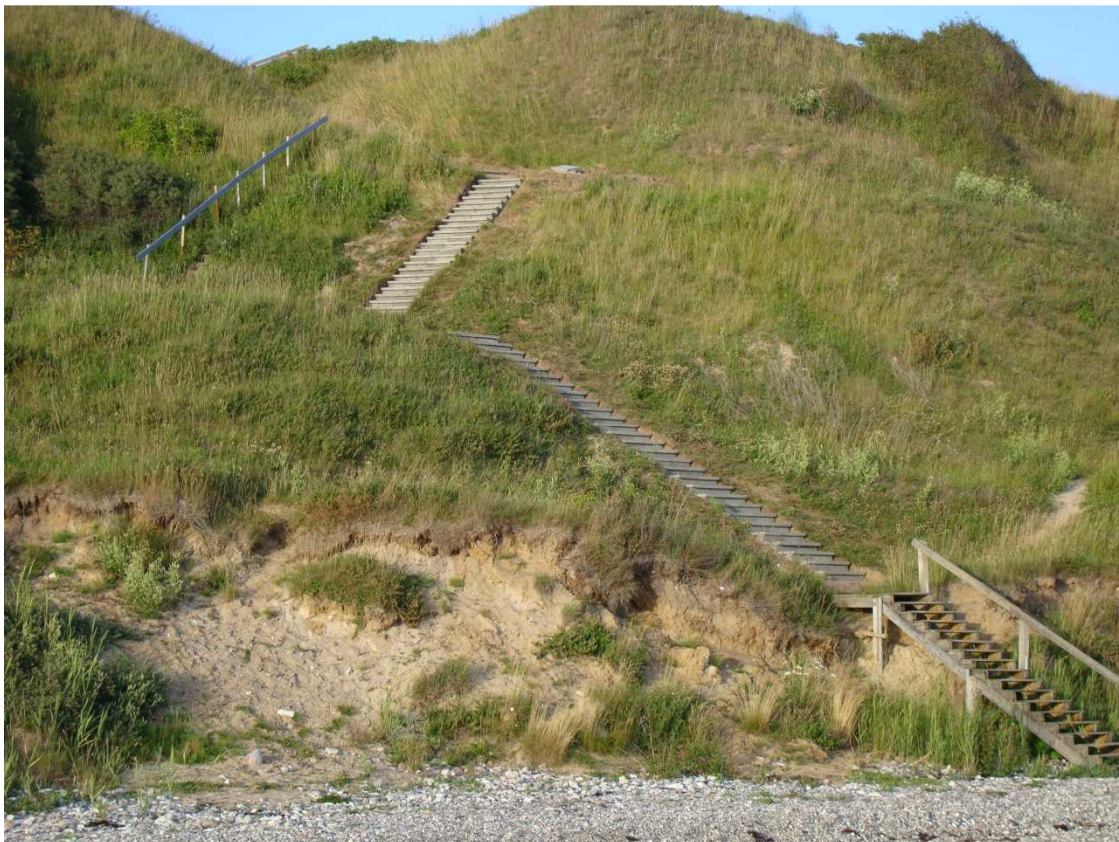
Nyetableret trappeanlæg indbygget i skrænten.
